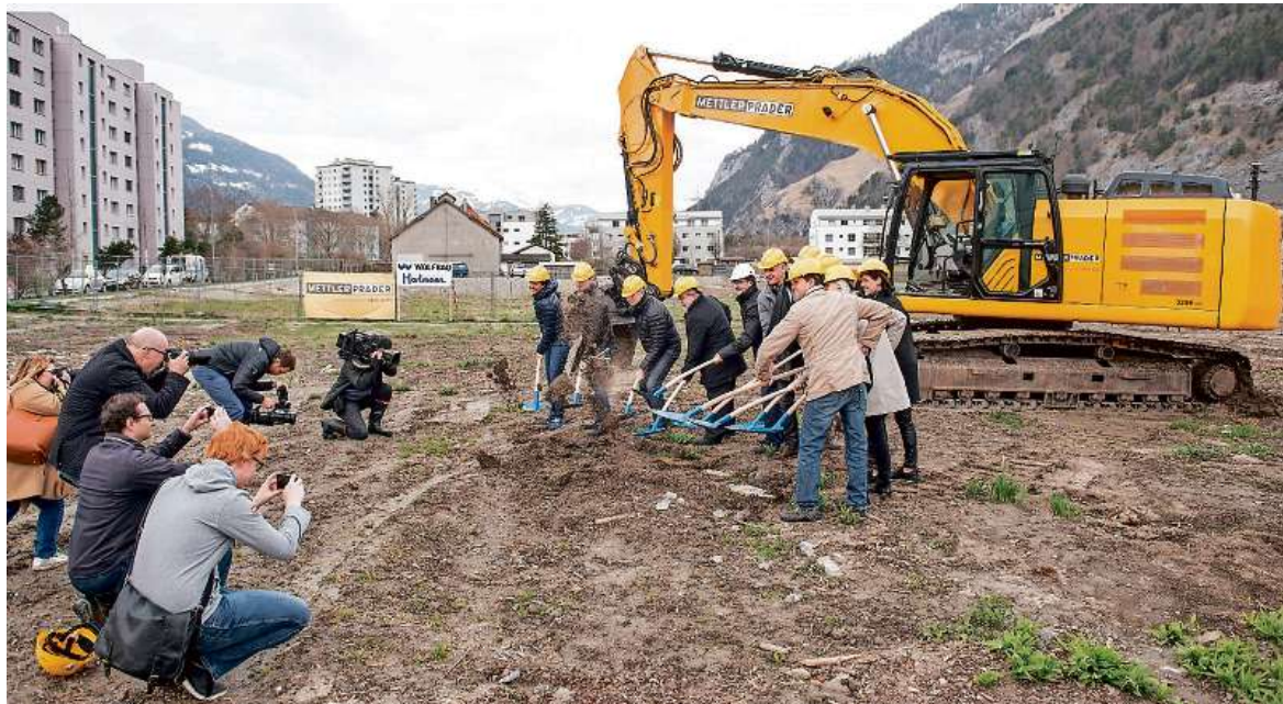
Symbolischer erster Spatenstich: Zwischen Austrasse und Schrebergärten wird in den nächsten zwei Jahren eine moderne Wohnbausiedlung entstehen. (FOTO OLIVIA ITEM)
