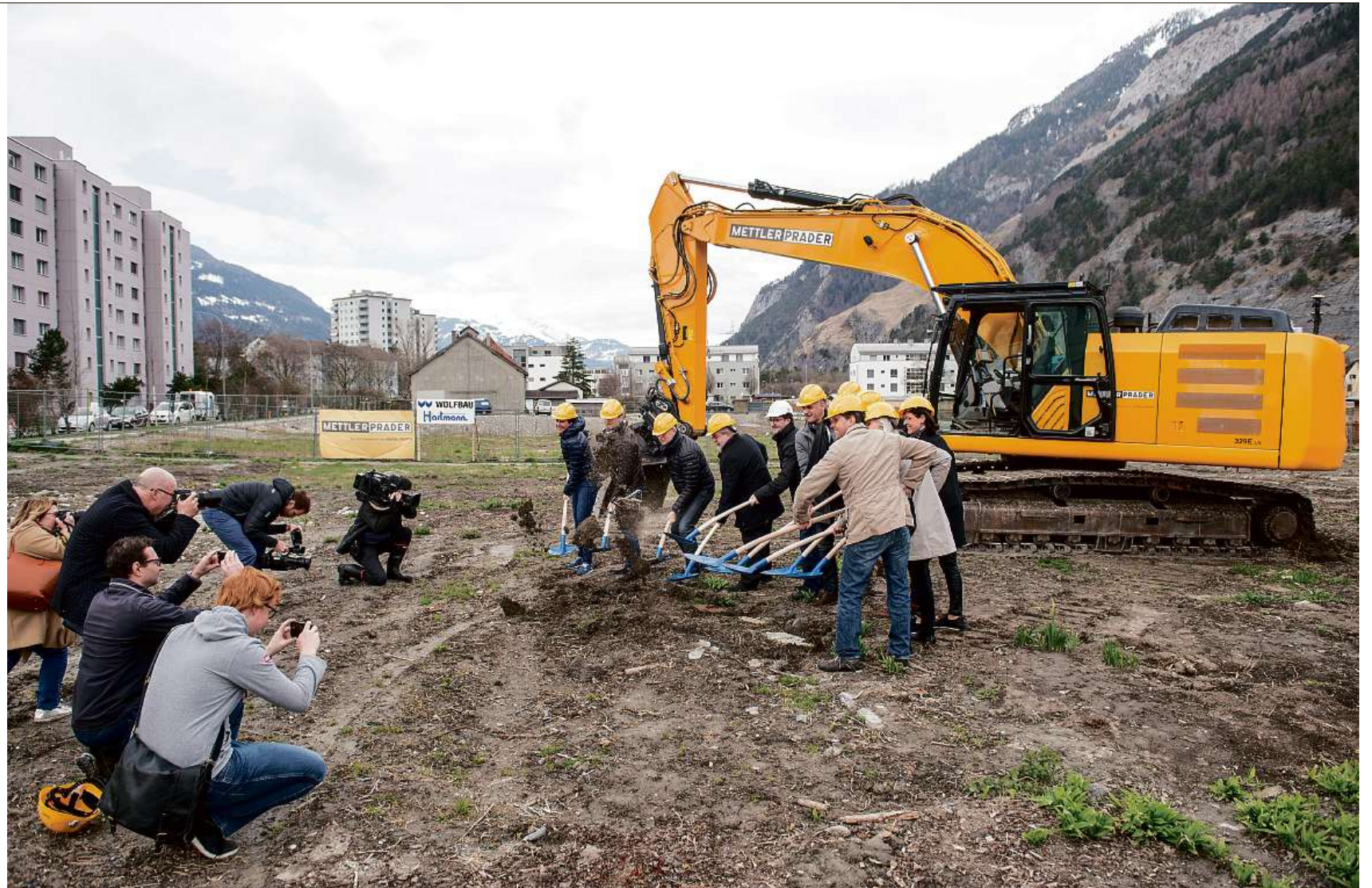
Startschuss zum Grossprojekt: Ein Bagger und viele helfende Hände der Bürgergemeinde Chur setzen auf dem Areal des ehemaligen Gaswerks zum Spatenstich an.
